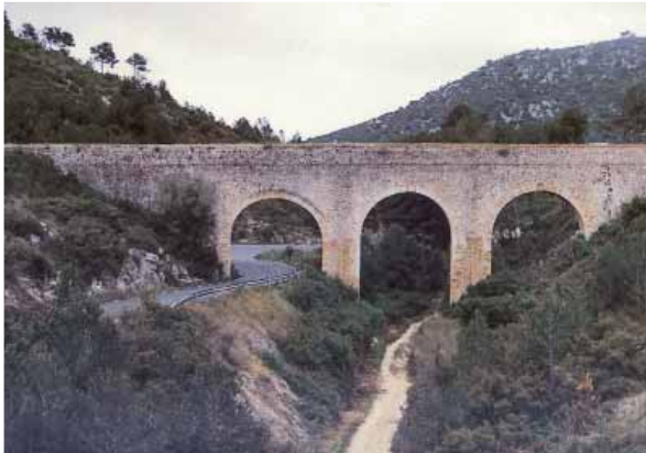
Aqüeducte construït per salvar el barranc de Coma Pineda, al seu pas per damunt de la carretera de Vilanova i la Geltrú a l'Arboç
